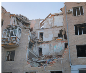
攻撃によって破壊された病院
